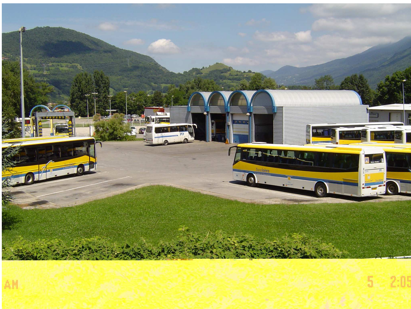
Figure 2 : Vue globale du Centre VFD de Vizille
