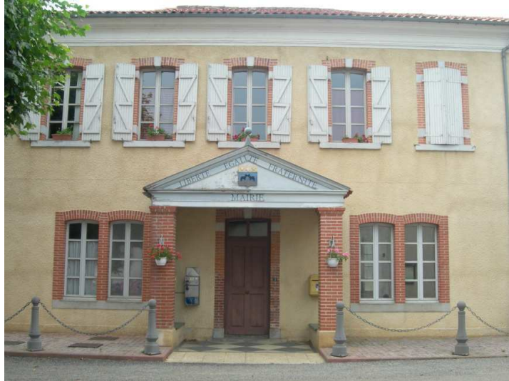
Mairie de Oueilloux
