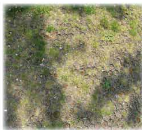
Photo 11 : Parking enherbé avec des alvéoles, laissant pénétrer l'eau dans le sol
