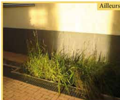
Photos 7, 8 et 9 : Système de récupération des eaux de pluie au sein d'un quartier (Malmö, Suède, 2010)
