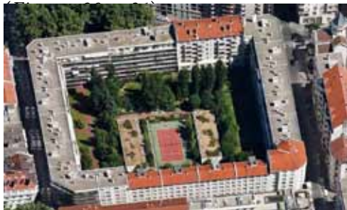
Figure 20 : Cœur d'îlot d'un seul bloc, mais sans connexion avec la rue (rue d'Arménie, Lyon. Source : Google maps, 2012)
