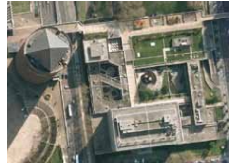
Figure 17 : Passerelle pour rejoindre la Tour de la Part-Dieu, plantations sur dalle. (Lyon 3ème, Google Maps, 2012)
