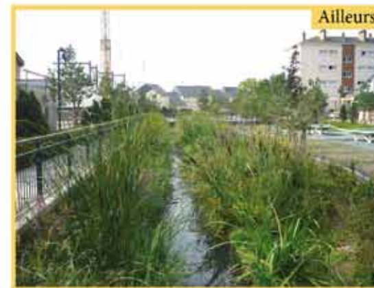
Photos 6: Autre exemple de noue paysagère recueillant les eaux d'un ensemble de parcelles (Trélazé (49), 2010)
