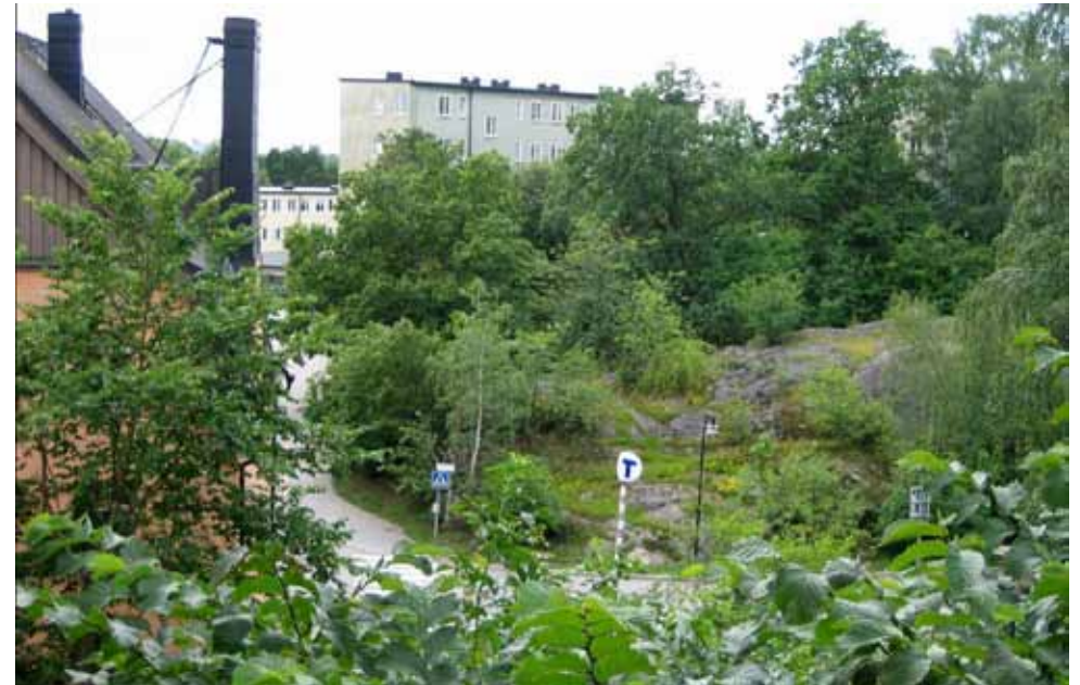
Figure 38 : Constructions intégrées dans la nature (Ekoparken Stockholm, source : DIREN Bretagne, 2007)
