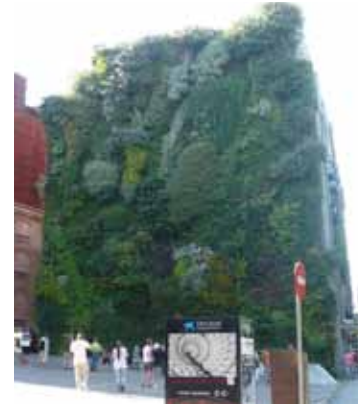
Figure 32 : Mur végétal (Madrid, C. Cassanet, 2011)
