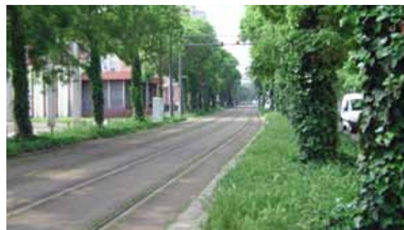
Figure 26 : Voie du tramway végétalisée (Lyon, C. Cassanet, 2012)
