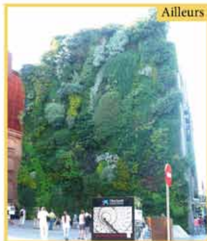
Photo 8 : Mur végétalisé (Madrid, juillet 2011)
