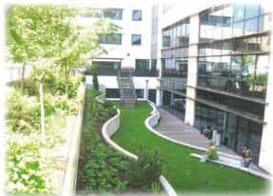
Photo 6 : Exemple d'utilisation d'une marge de recul du bâtiment par rapport à la voirie : espace collectif de la cantine ouvert à la vue du public créant une sorte d'espace tampon entre les espaces publics et privés (bureaux à proximité zac de la Buire, Lyon 3ème, mai 2012)
