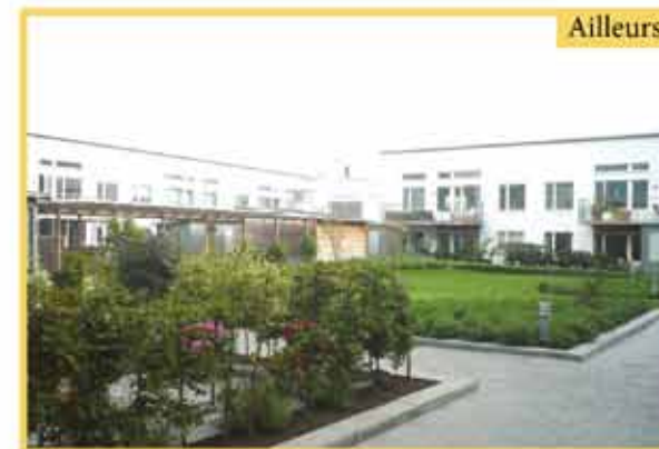
Photo 8 : Cœur d'îlot ouvert et profitable à tous les habitants ainsi qu'aux passants s'y aventurant (Lomma, Suède, septembre 2010)
