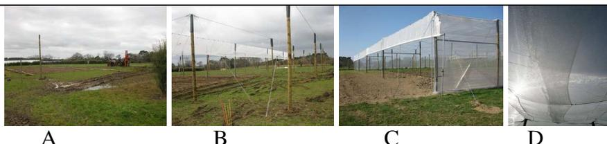
Montage de l'Abri 1 (A et B). Caractéristiques : ouverture côtés Ouest (C) et Est. Filet en toiture présentant une zone de recouvrement (D) (SEHBS, 2011).
