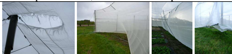
Dégâts sur l'abri 1 suite aux épisodes venteux de décembre 2011 et Avril 2012 (SEHBS, 2011 et 2012)
