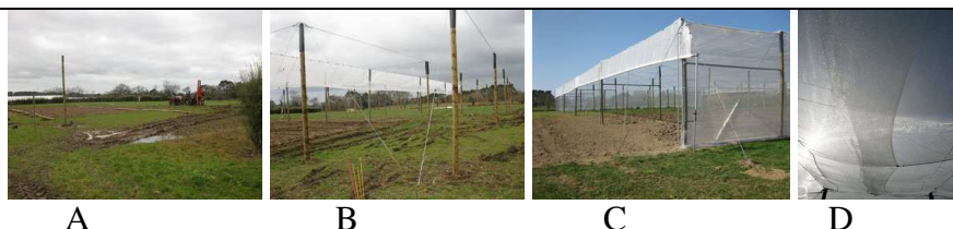
Montage de l'Abri 1 (A et B). Caractéristiques : ouverture côtés Ouest (C) et Est. Filet en toiture présentant une zone de recouvrement (D) (SEHBS, 2011).
