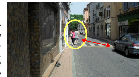
Figure 18 : Une largeur de trottoir inadaptée pour les piétons à Pont-de-Beauvoisin (38) - G.L. 2012
