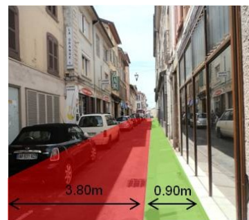
Figure 10 : Comparaison de la largeur de la chaussée et du trottoir dans une rue de Bourgoin-Jallieu (38) - G.L. 2012
