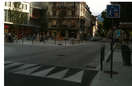
Figure 59 : Zone de rencontre - porte d'entrée, plateau ralentisseur et changement de revêtement - G.L. 2012
