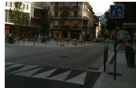
Figure 59 : Zone de rencontre - porte d'entrée, plateau ralentisseur et changement de revêtement - G.L. 2012
