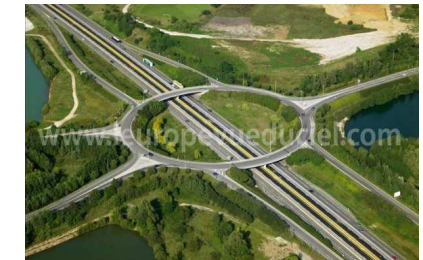
•4.a• Echangeur routier de l'A36, Doubs, L'Europe vue du ciel, 2007
