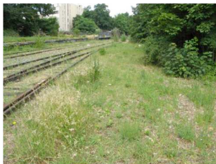
Figure 1 : Photo prise hors site (voie ferrée non accessible)
