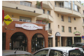
(2) Présence de commerces en rez-de-chaussée
