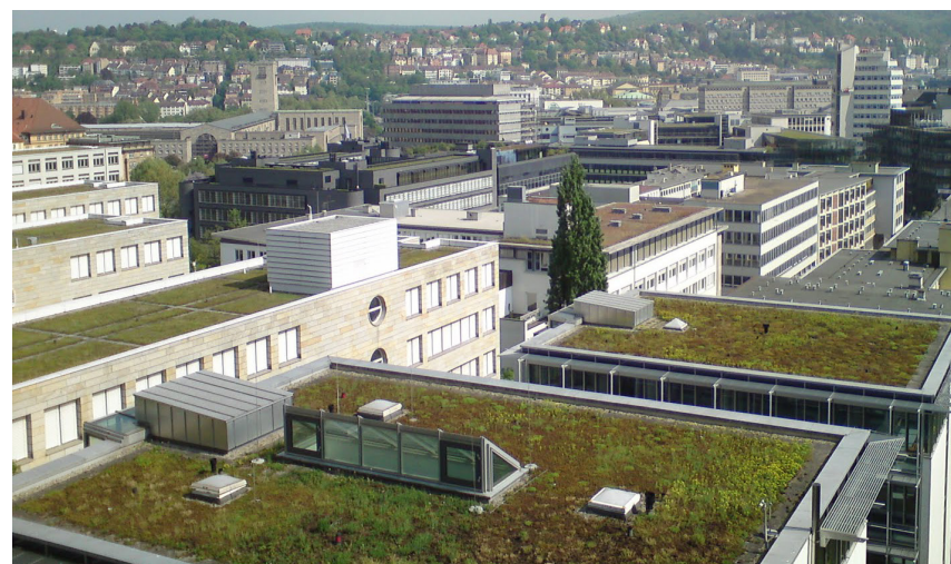
Figure 10 : Mayenne - Toits d'immeuble végétalisés http://engeespromomayenne.blogspot.fr
