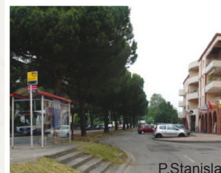
(3) Contre allée longeant la D2
