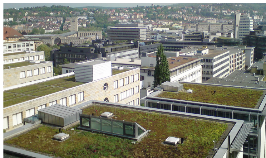
Figure 10 : Mayenne - Toits d'immeuble végétalisés http://engeespromomayenne.blogspot.fr
