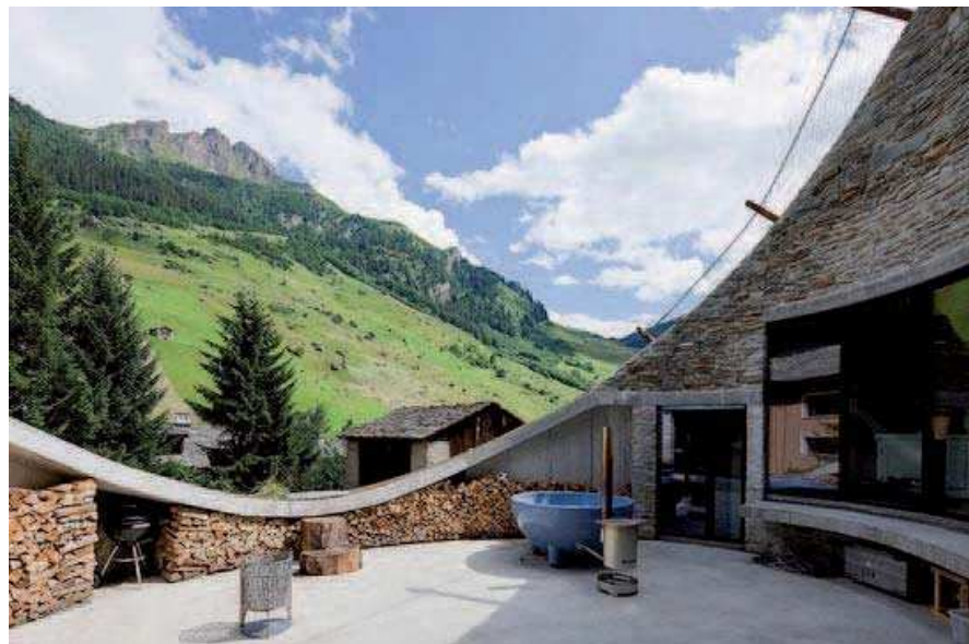
50 - Photographies de thermes de Vals et de la Villa Vals, architecture: SeARCH. Date NC, Iwan Baan
