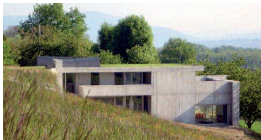
34 - Photographie d'une maison intégrée au dénivelé du terrain à La Motte-Servolex (73). 2004, © Erick SAILLET
