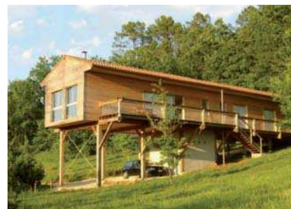
32 - Photographie d'une maison sur pilotis, les Arques (46). Juillet 2008, Auteur NC (Source internet)
