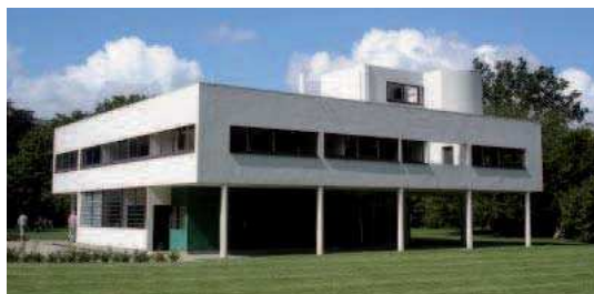
12 - Photographie de la Villa Savoye à Poissy (78). Architecte Le Corbusier, 1929. 2003, Anriet Denis
