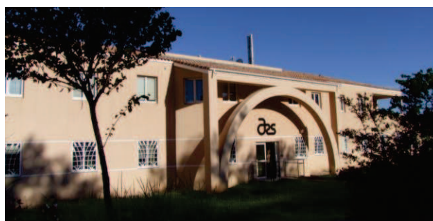
Figure 2 : façade du bâtiment principal de l'EBCL
