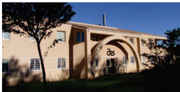
Figure 2 : façade du bâtiment principal de l'EBCL
