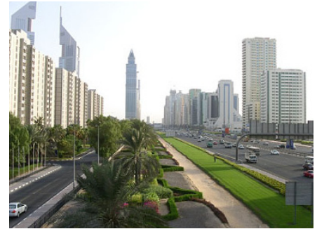
Boulevard urbain Dubai
