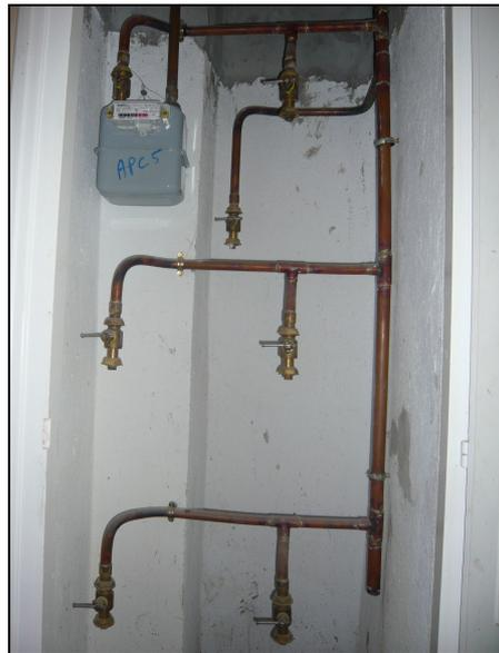
*Illustration II-15 : placard à compteurs dans l'immeuble cité ci-dessus : l'installation en cuivre est réalisée, mais les habitants ne disposent pas tous d'un compteur gaz naturel. Photo HB, 2012.*
