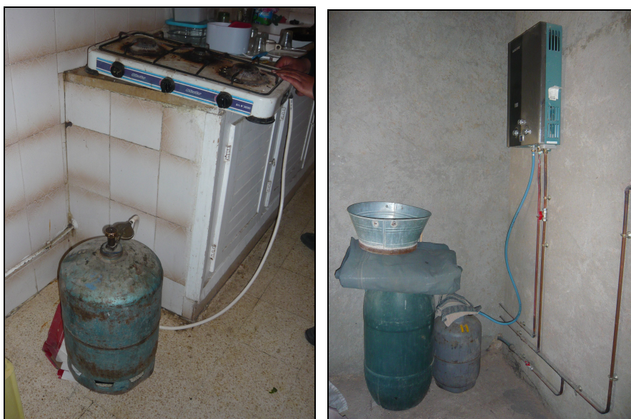
Illustrations II-12 : exemples d'utilisations de bouteilles de GPL pour la cuisine (cliché pris dans un ménage sfaxien, quartier de Sfax El Jadida) et pour le chauffage de l'eau (cliché pris dans un ménage de Mareth, au sud de Sfax). Photo HB, 2012.
