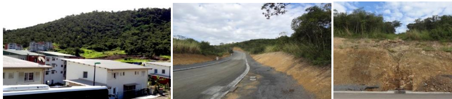
Fig. 16 : Constructions à proximité directe de la FS (Pic aux Chèvres) ; FS divisée en deux pour le tracé d'une voirie (Trois Vallées) ; Canal d'évacuation des eaux de pluies (13 m de large au lieu des 3 m autorisés) (Trois Vallées)
