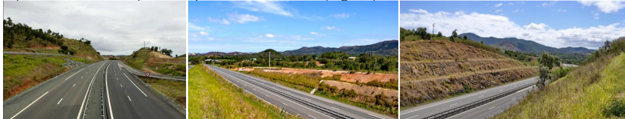
Fig. 22 : Espaces restaurables le long de la SAVEXPRESS : Au niveau de Dumbéa et ZI de Païta (ZIZA) (au loin le Pic Jacob et les Monts Nondoué).
