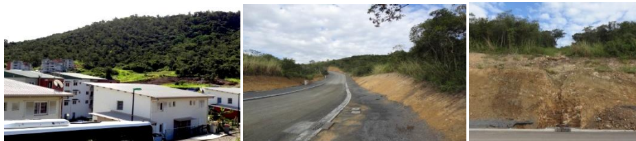
Fig. 16 : Constructions à proximité directe de la FS (Pic aux Chèvres) ; FS divisée en deux pour le tracé d'une voirie (Trois Vallées) ; Canal d'évacuation des eaux de pluies (13 m de large au lieu des 3 m autorisés) (Trois Vallées)
