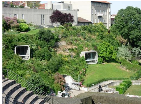
7.2.4 Vue des baies vitrées du musée gallo-romain de Lyon-Fourvière
