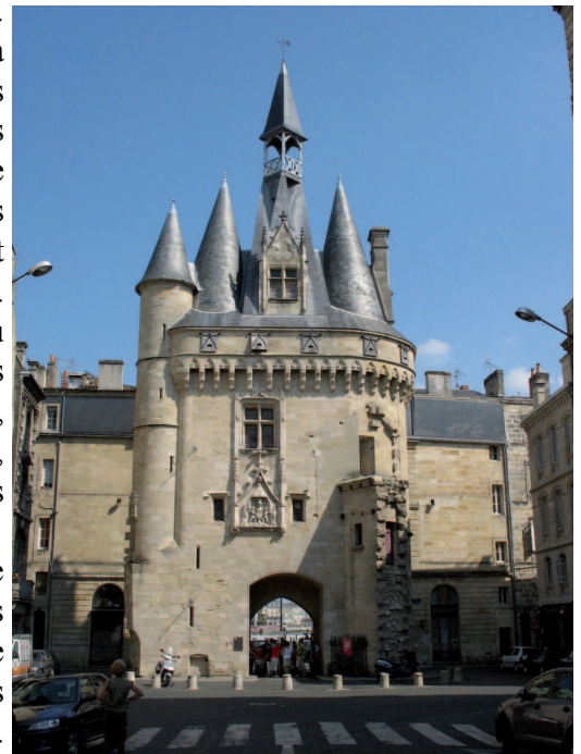
Figure 2. Porte Cailhau, architecture montrant la force et la richesse de la ville. Bordeaux. Source : lisezmoi.blogspot.fr
