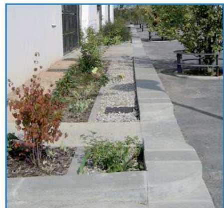
Figure 33 : Schéma d'une tranchée drainante (à gauche) et tranchée d'infiltration à Lyon (à droite) (GUIDEnR)
