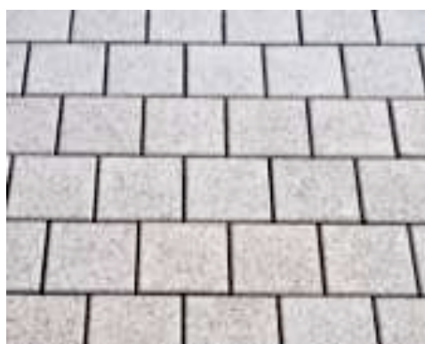
Figure 39 : pavés préfabriqués en béton drainant (Kronimus)
