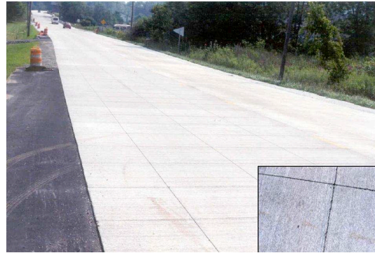
Figure 37 : resurfacement d'une route en asphalte avec du béton (Golder 2011)
