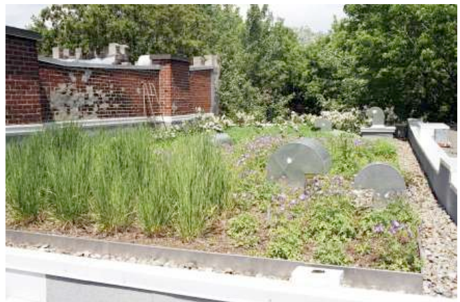
Figure 25 : exemple de toit vert extensif, duplex, centre-ville de Montréal (Guthrie 2011)
