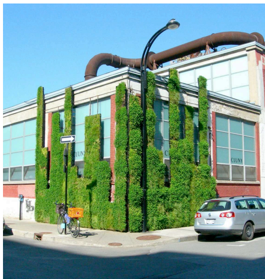
Figure 22 : Mur végétal de la fonderie Darling (Catalyse Urbaine 2007)
