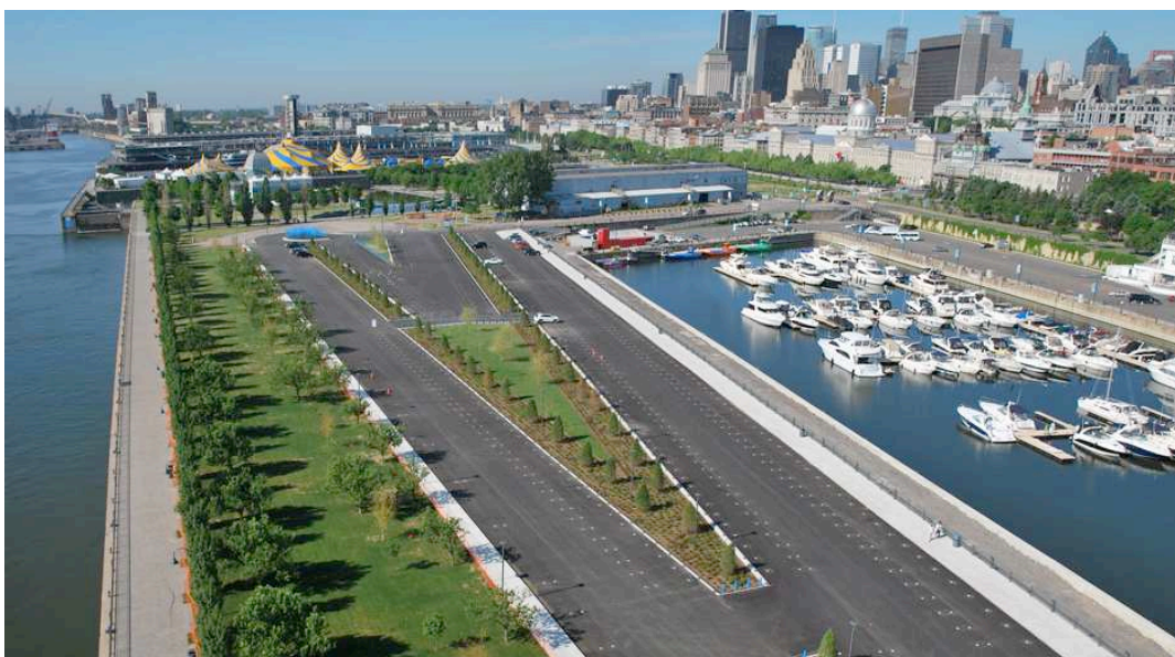
Figure 32 : parking du Quai de l'Horloge à Montréal (Cormier & Associés 2012)
