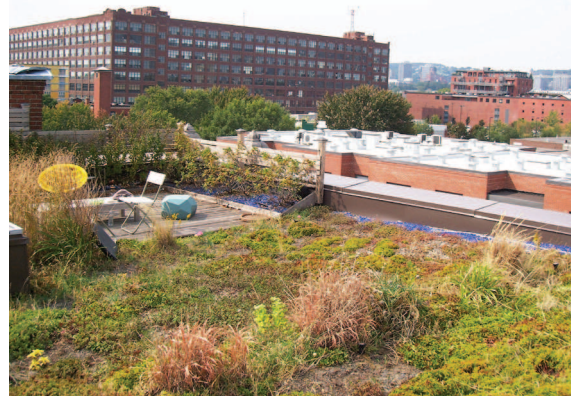
Figure 30 : Toit de l'agence Catalye Urbaine, Montréal, 2012 Source L.C.
