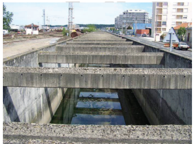
Figure 23 : Endiguement du ruisseau de l'Ars (LEJAMTEL, 2012)
