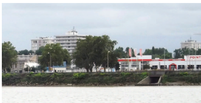
Figure 27 : Vue des berges et l'exutoire du ruisseau de l'Ars depuis la rive droite ( LEJAMTEL, 2011)
