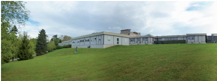
Figure 13 : Une rupture de pente. Source : S. Chevillard, 2012
