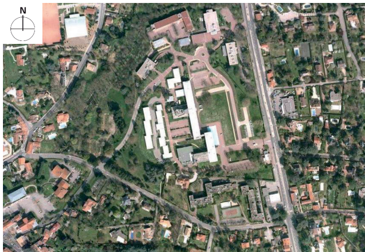
Figure 9: Vue aérienne du site. Source : Programme projet Charbonnières, 2012
