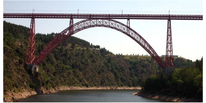
Fig. 3: Photographie du Viaduc de Garabit de face (source : Google images )
