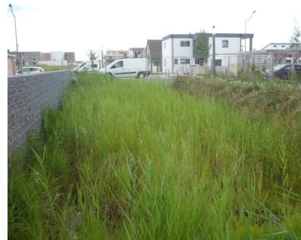
Figure 20: Eco-quartier « la roselière » d'Obernai. Les eaux pluviales et issues des surfaces imperméables sont collectées dans des noues plantées de roseaux pour assurer la filtration et l'infiltration de l'eau. (B. Marion, 2012)
