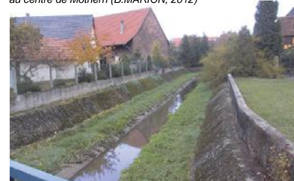
Figure 50 : le Kleinbach avant les aménagements (B.MARION, 2012)
