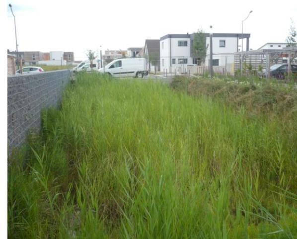
Figure 20: Eco-quartier « la roselière » d'Obernai. Les eaux pluviales et issues des surfaces imperméables sont collectées dans des noues plantées de roseaux pour assurer la filtration et l'infiltration de l'eau. (B. Marion, 2012)
