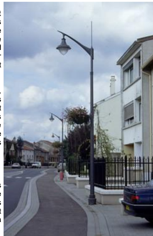
Figure 79 : La traverse de Blénod-lès-Pont-à-Mousson était un exemple de voirie uniquement en enrobé et la végétalisation n'est possible qu'avec des suspensions. Ces types d'aménagements ne correspondent pas aux objectifs du référentiel (CAUE54, 2005)
