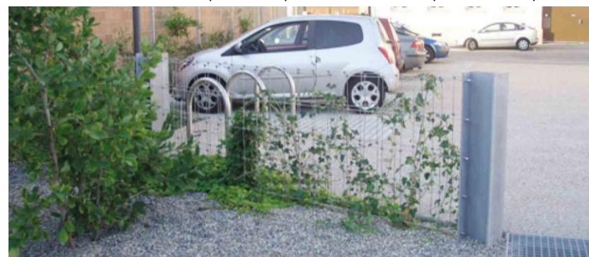
Parking à revêtement en béton et gravier et clôtures végétalisées
