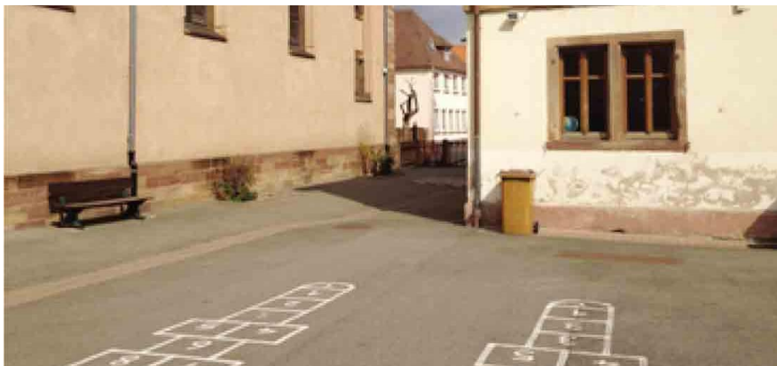
Cour d'école en enrobé à fort impact minéral et peu praticable par les écoliers
