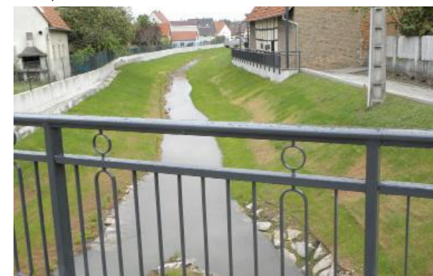
Figure 51 : Le Kleinbach après aménagement (B.MARION, 2012)
