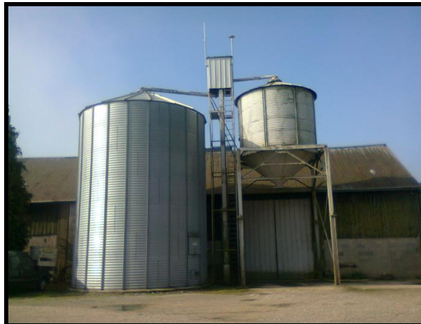
Figure 14 Installation de stockage chez un céréalier francilien commercialisant du pain en circuit court (source : DRIAAF- stage L.Jolly, 2012)
