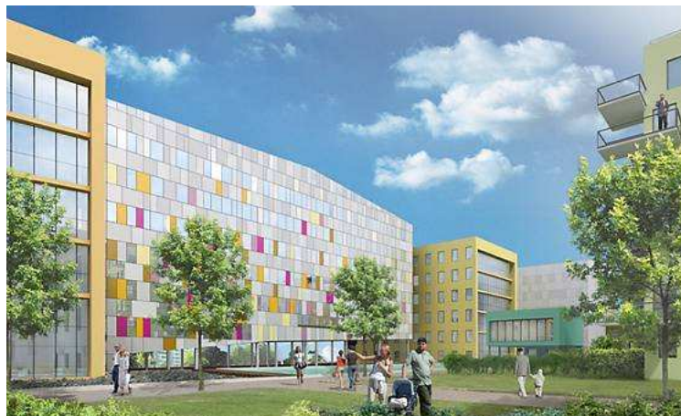
Fig. 4.5 – La nature des revêtements des façades de bureaux de Tripode : principe de voile percé. Les tôles d'aluminium sur allèges de béton ou de verre émaillé sont en alternance avec de vitrages émaillés de différentes teintes [SAMOA 11].
