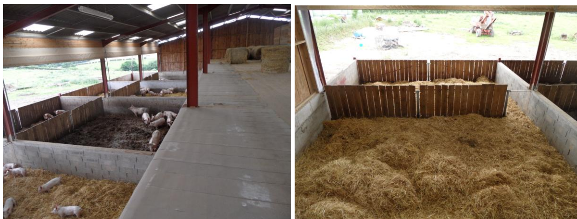
Ci-dessus : cases du bâtiment, vu du grenier de stockage de l'aliment et de la paille.
