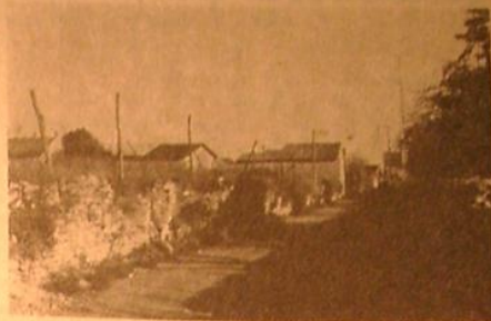
CORCET. — Route en mauvais état, murs qui s'écroulent, eau qui stagne sur les bas côtés.
