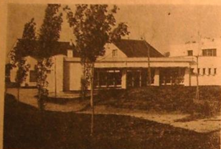
NAINTRE. — L'Ecole Maternelle sera la pièce maîtresse de l'inauguration du 22 novembre.
