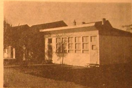
L'installation d'une cantine scolaire à Chezelles a été une des premières réalisations de la Municipalité.
