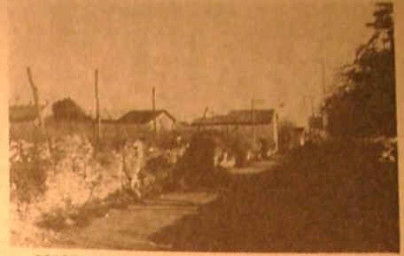
CORCET. — Route en mauvais état, murs qui s'écroulent, eau qui stagne sur les bas côtés.
