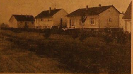
NAINTRE. — Les Lotissements des Tailles Rottes montrent l'effort de la Municipalité en faveur de la construction individuelle.
