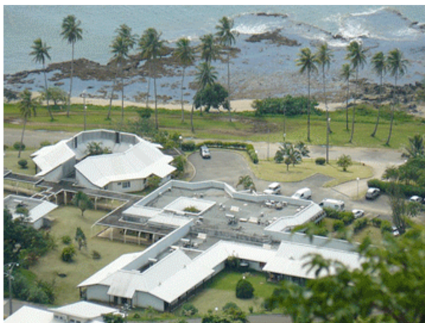
Figure 5. Centre Hospitalier du Nord (CHN) de Poindimié abritant l'unité de dialyse ATIR NC ( atir.asso.nc )
