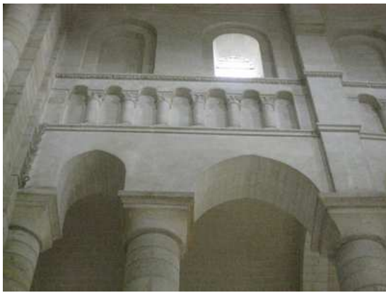
Arcade, arcature aveugle, fenêtre du chœur
