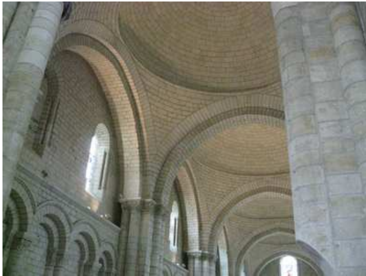
Vue sur les galeries et les piles des coupoles
