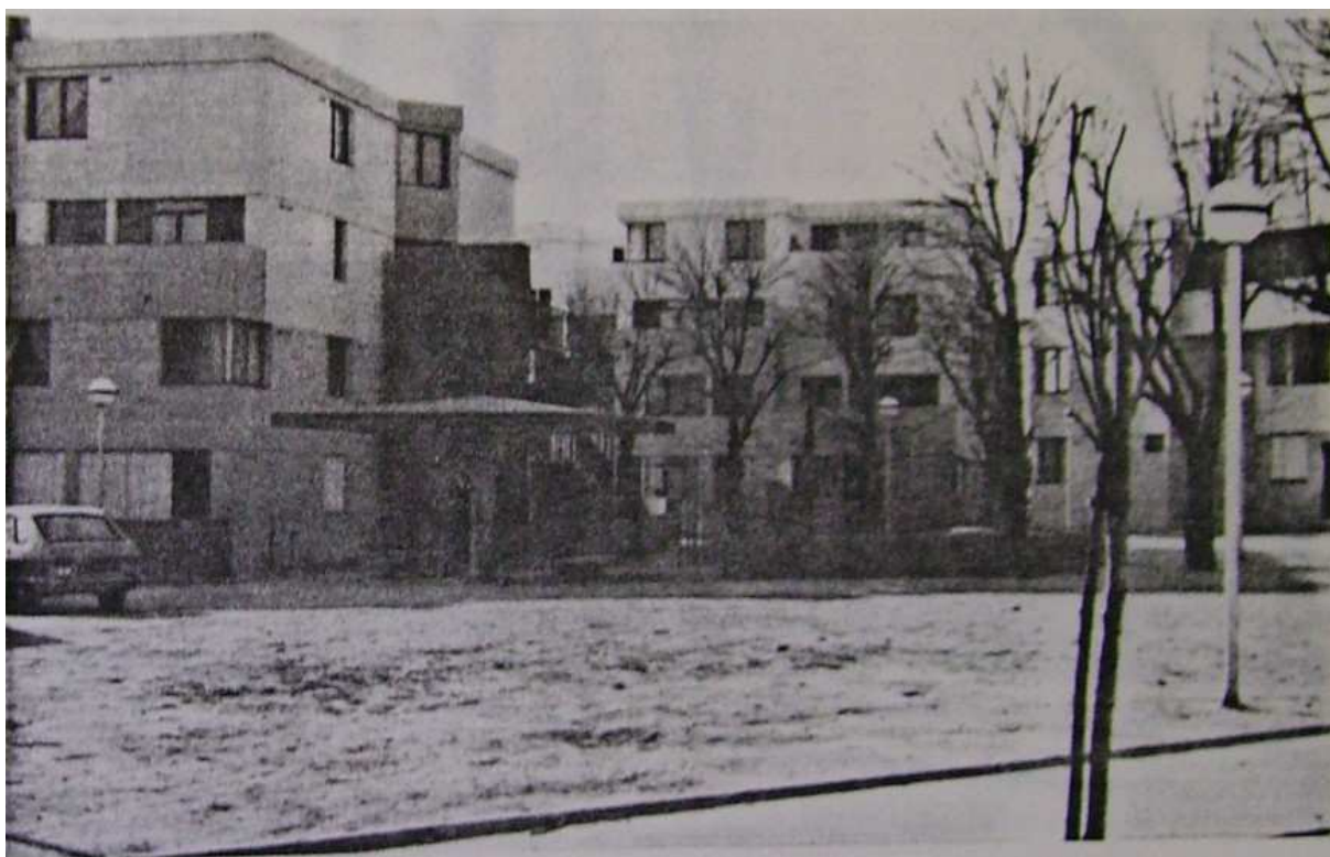
Vue d'ensemble de la cité des Tilleuls II après rénovation en 1980.
