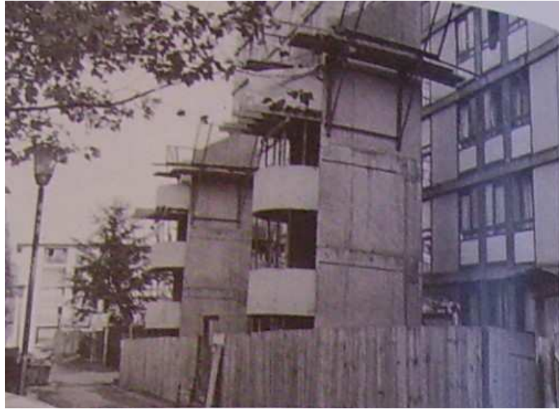
Construction des escaliers extérieurs (1984)
