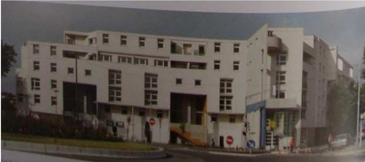
Nouveaux immeubles de la Z.A.C. des Nouvelet
