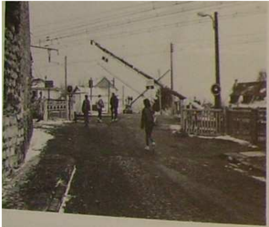
Passage à niveau de la rue Maréchal Foch
