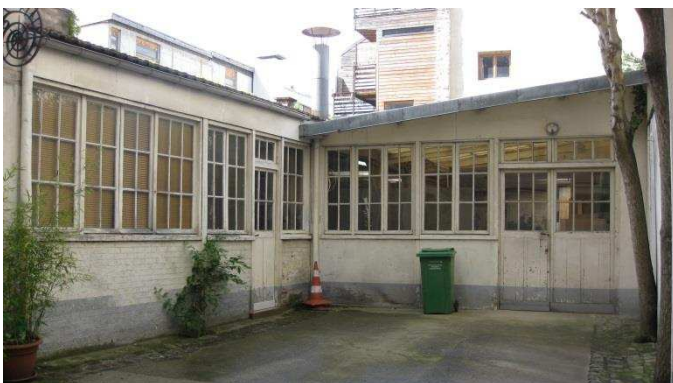
Figure 11 79 , Atelier de l'entreprise Marciano, meubles et agencements, situé rue des Haies
