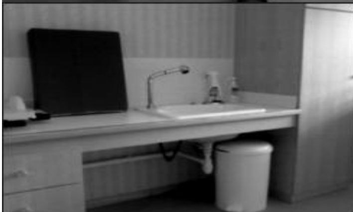
Figure 11 : Plan de travail abaissé dans la chambre adaptée au handicap moteur en suites de couches
