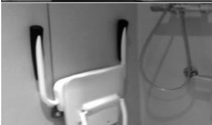
Figure 10 : Douche adaptée aux personnes handicapées avec un strapontin (chambre de suites de couches)
