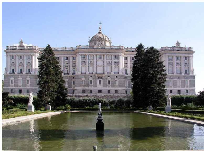
Palais Royal actuel (façade nord)
