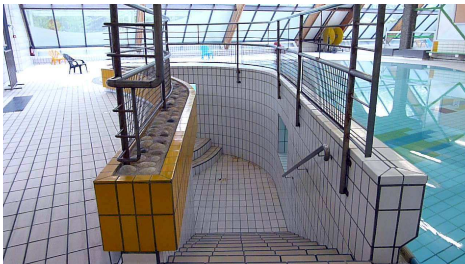
FIGURE 15: ESCALIER MENANT AUX FENETRES SUBAQUATIQUES
