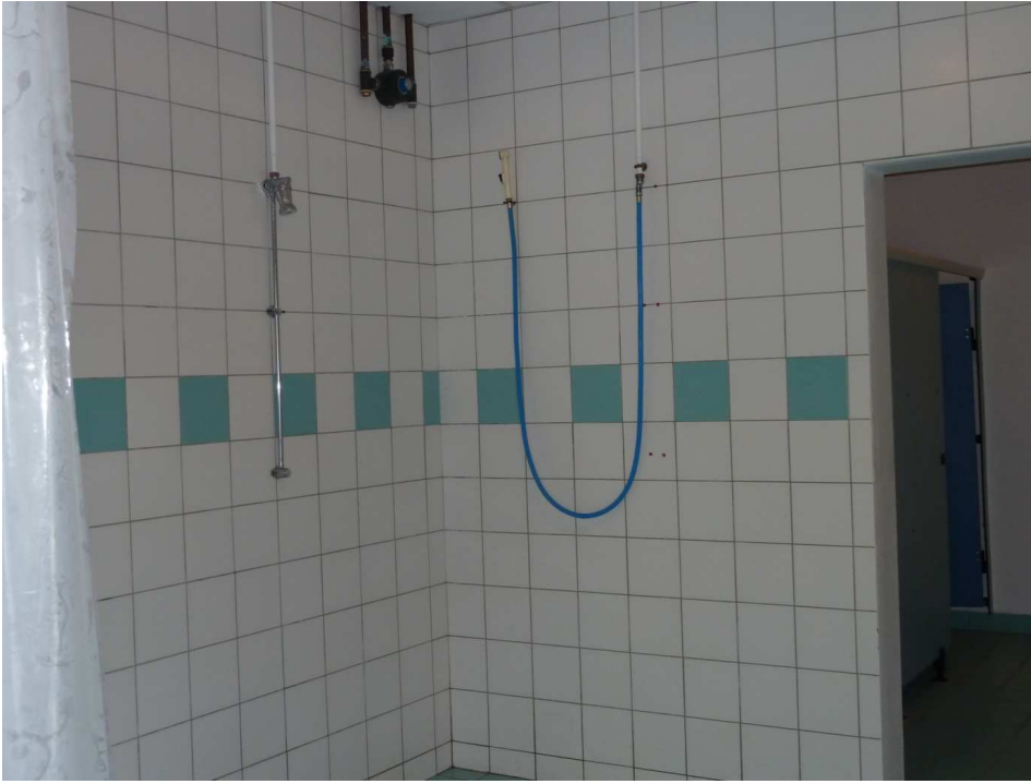
FIGURE 11 : DOUCHE AVEC POMMEAUX FIXES ET MOBILE
