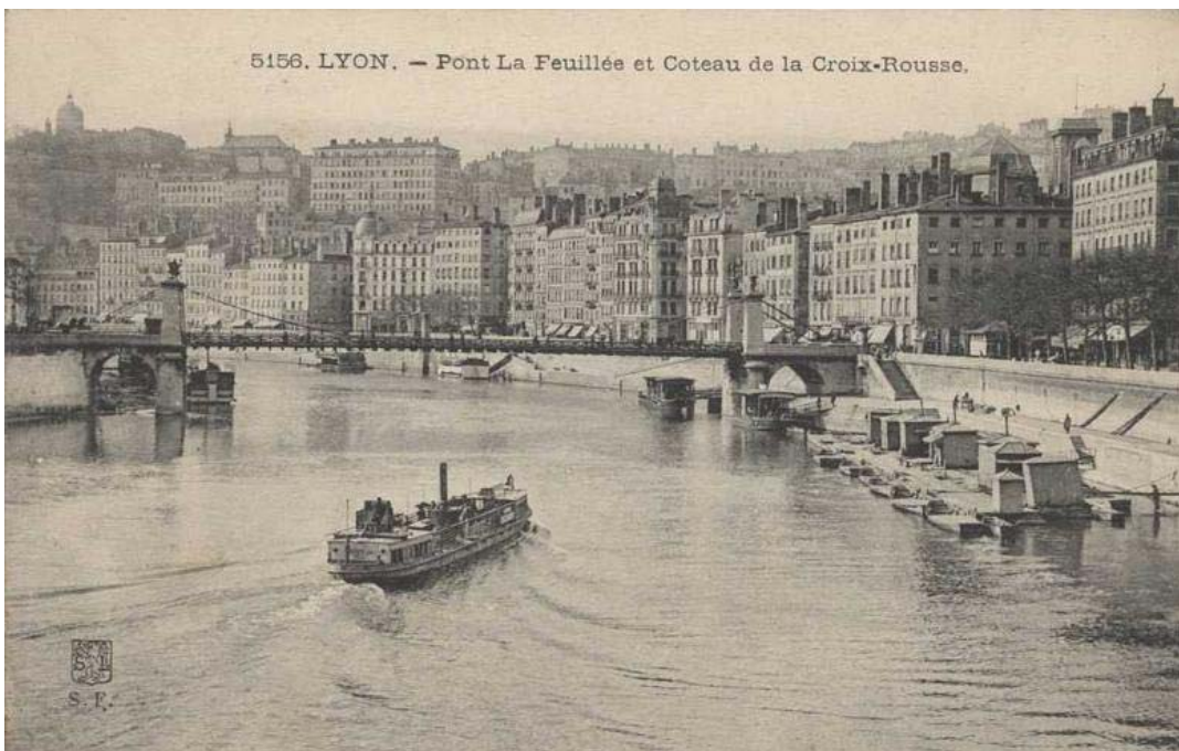
Arrivée d'un omnibus au ponton de La feuillée (A.M.L., 4FI_3289).
