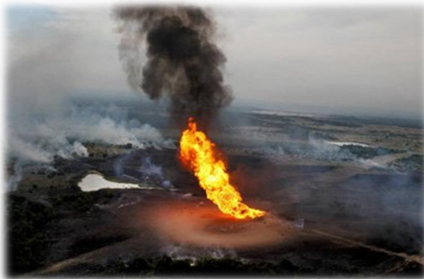
Figure 1 : Explosion de gaz naturel entre Cleburne et Granbury (Texas)
