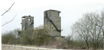
Lottinghen : Reconversion d'une ancienne carrière d'environ 9 hectares et ses bâtiments.
