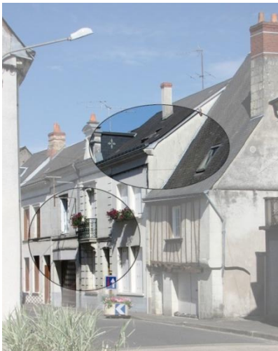
Figure 9 : Front bâti avec murs en tuffeau et toits en ardoise, Cheillé (source, J.ANTUNES-VALLEREY, 2013)
