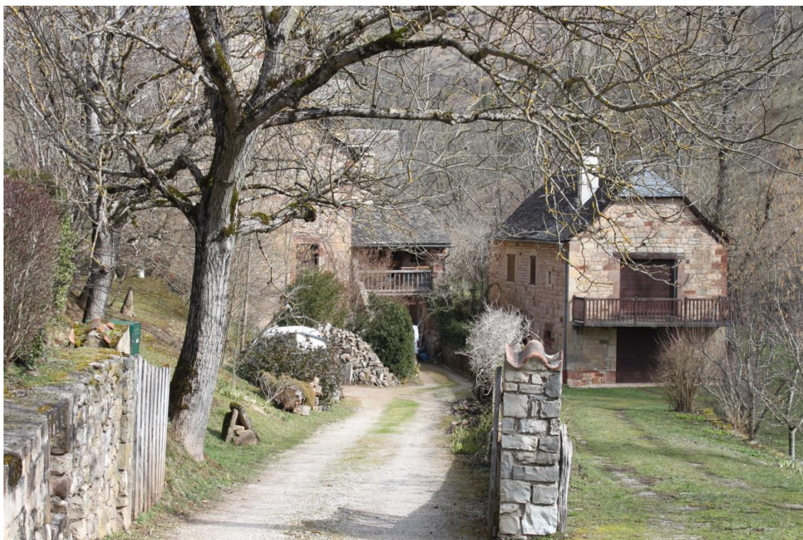
Figure 101 : Maison de vigne dans la vallée de Grand-Combe
