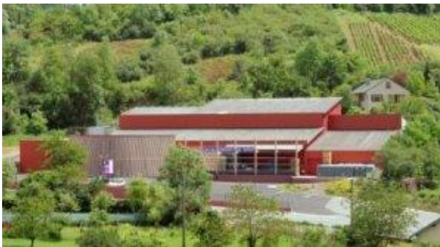
Figure 22 : Extérieur de la cave coopérative de Valady 1
