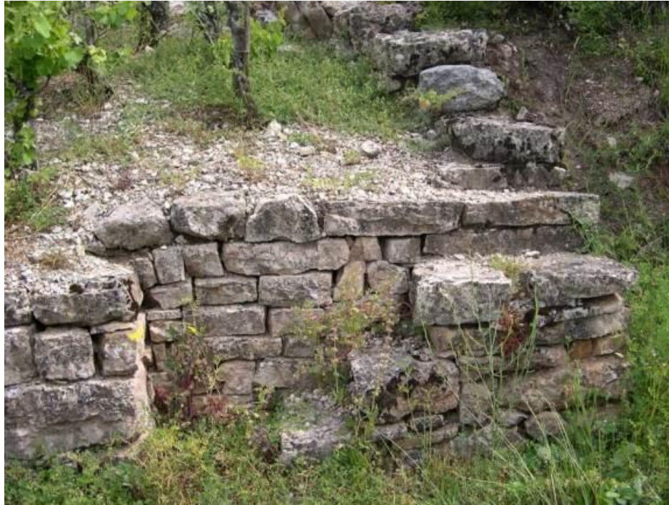
Figure 51 : Escalier et paremons d'une vigne à Balsac 1
