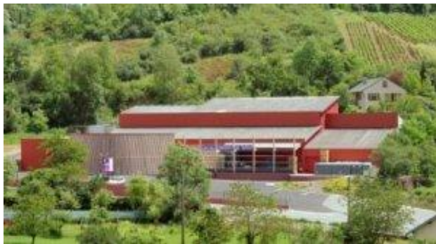
Figure 22 : Extérieur de la cave coopérative de Valady 1
