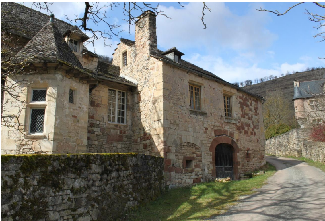
Figure 100 : Maison de vigne avec tour dans la vallée de Grand-Combe 1
