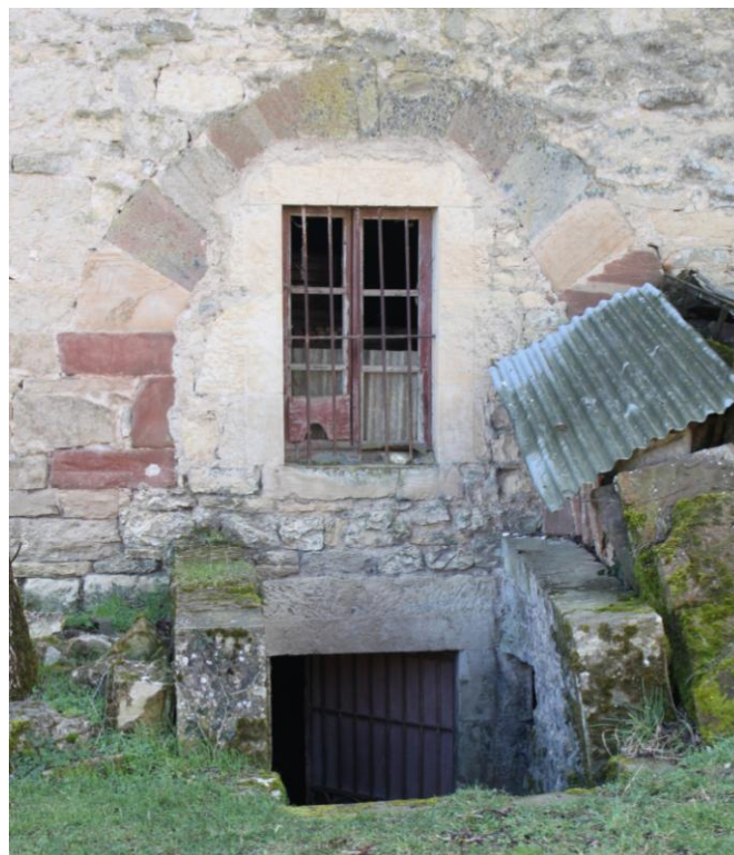
Figure 107 : Cave en sous-sol à Gradels 2
