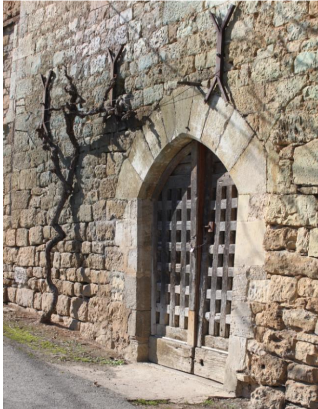
Figure 106 : Cave avec pied de vigne à Saint-Austremonie 1
