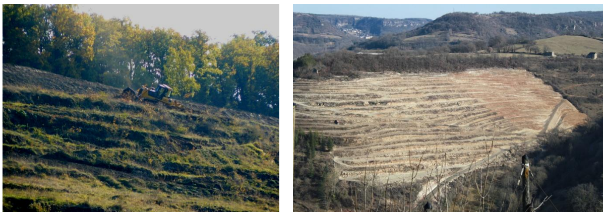
Figure 27 : Travaux à la pelle mécanique pour faire les nouvelles terrasses 2
