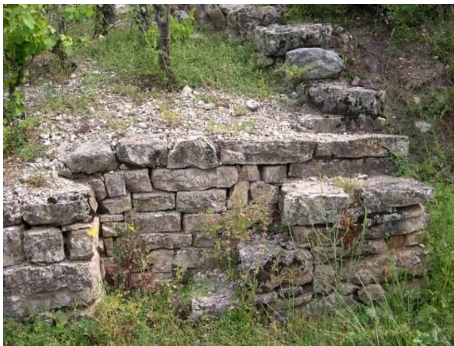
Figure 51 : Escalier et paremons d'une vigne à Balsac 1
