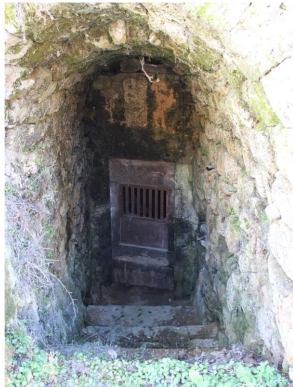
Figure 60 : Escalier permettant l'accès à la cave 2
