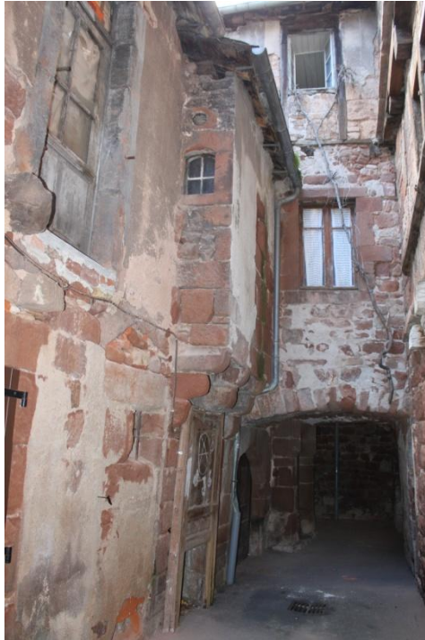
Figure 58 : Ruelle de Marcillac-Vallon passant sous de vieilles bâtisses 1
