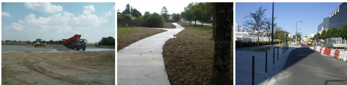
Figure 3 : Illustration de la diversité des typologies de chantier (de gauche à droite : Terrassement et empierrement d'une plate forme de 5000m<sup>2</sup> (Saint Germain Sur Moine – 49), Cheminements en béton balayé (La Roche Sur Yon – 85), Plantation et mobilier (Ile de Nantes – 44) (Gourvès, 2013).
