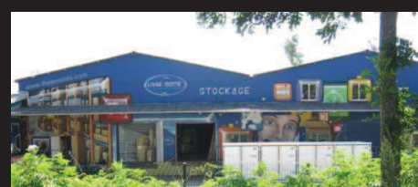
Fig. 51 : Un bâti à caractère industriel
