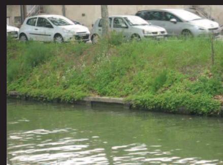
Fig. 25 : Une rive droite non aménagée pour les piétons
