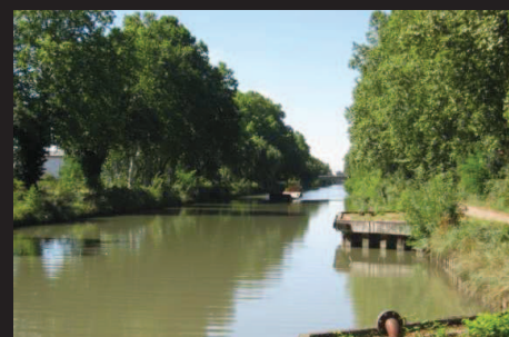
Fig. 47 : Un canal ouvert et dégagé
